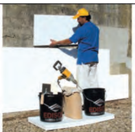
Fase 3: Posa del pannello
