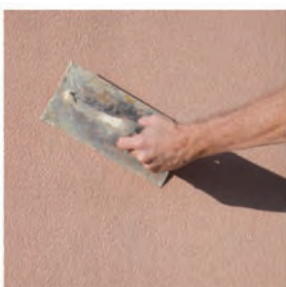
Fase 7: Stesura terzo ciclo di rasante a copertura della rete
