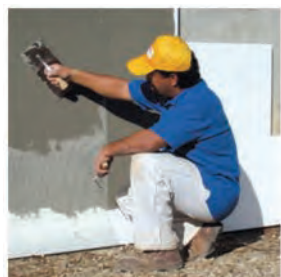
Fase 6: Stesura secondo ciclo di rasante con inserimento di rete in fibra di vetro
