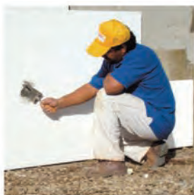
Fase 4: Fissaggio e stuccatura del tassello
