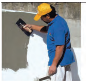
Fase 5: Stesura primo ciclo di rasante
