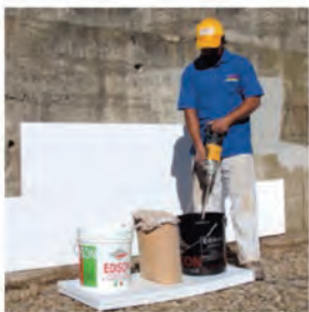
Fase 1: Miscelazione della malta con miscelatore elettrico manuale o carrellato
