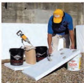
Fase 2: Stesura della malta su pannello o con spatola dentata sul supporto
