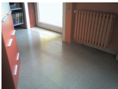
Figura 7.33 - Uscita di sicurezza
