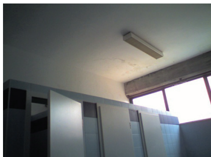
Figura 7.25 - Bagni di un edificio scolastico
