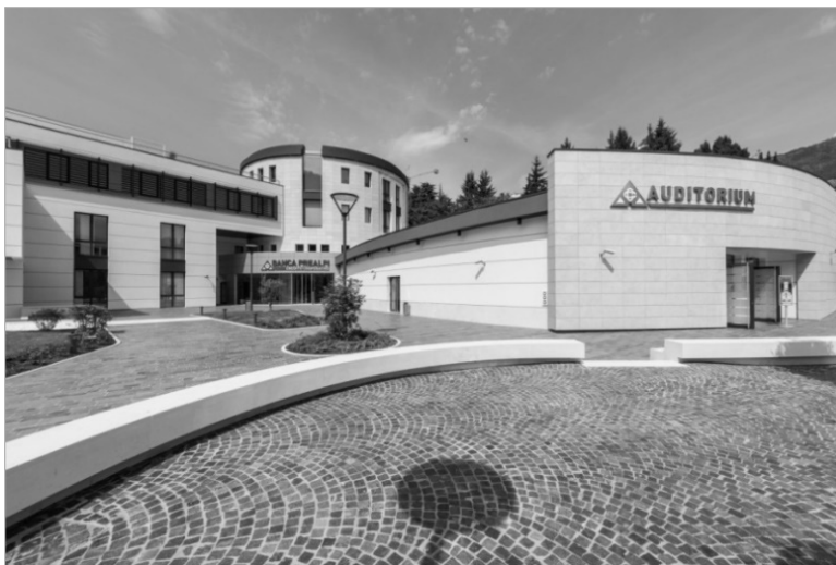
Figura 32.3 - Lo stato finale: veduta dell'auditorium
