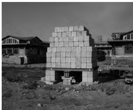
Figura 121 - Predisposizione del carico per prova di carico diretta (4EMME)
